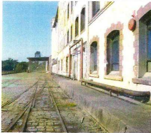
Imagem 20. Detalhe do pátio pavimentado com paralelepípedos, entre a edificação principal e o alinhamento do rio, com os trilhos que davam acesso ao Moinho. Data: Junho/2013. Fonte: CPC.
