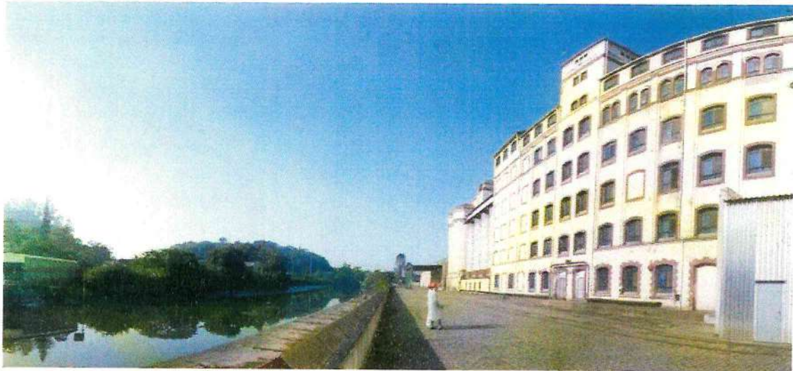
Imagem 19. Detalhe do pátio pavimentado com paralelepípedos, entre a edificação principal e o alinhamento do rio, com os trilhos que davam acesso ao Moinho. Data: Junho/2013. Fonte: CPC.
